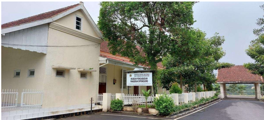
Gb. 03 Foto tampak selatan bangunan eks Rumah Dinas Residen Kedu
