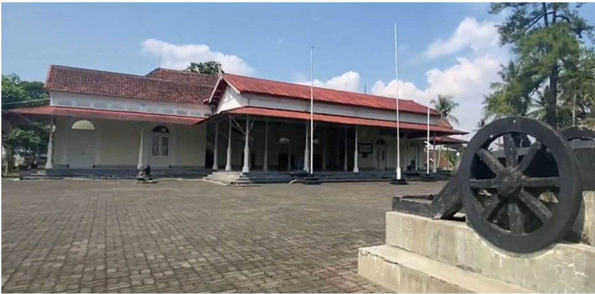
Gb. 01 Eks Rumah Residen Kedu tampak barat
