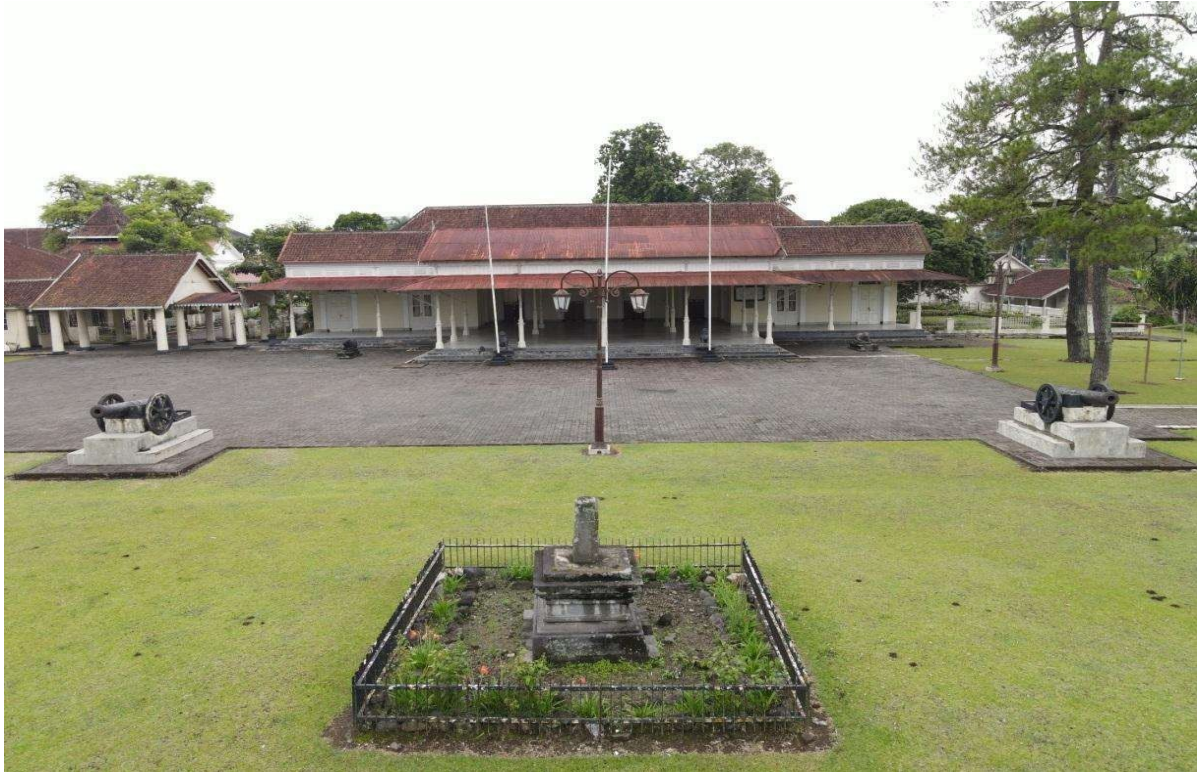
Gb.05 Foto tampak barat bangunan Rumah Dinas Kepala Badan Koordinasi Wilayah II Magelang
