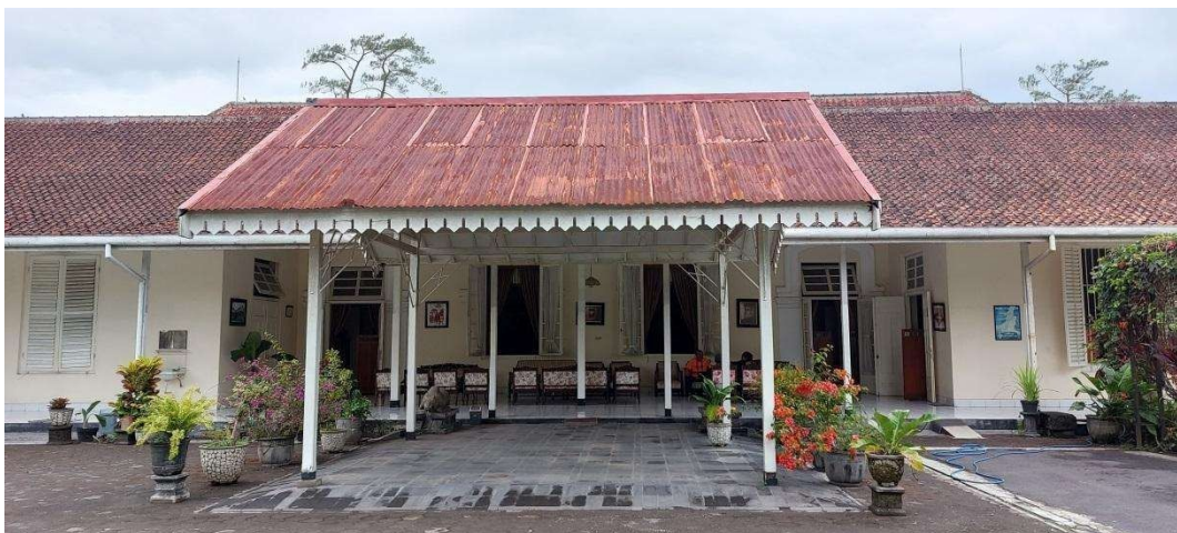
Gb.04 Foto tampak timur bangunan Rumah Dinas Kepala Badan Koordinasi Wilayah II Magelang
